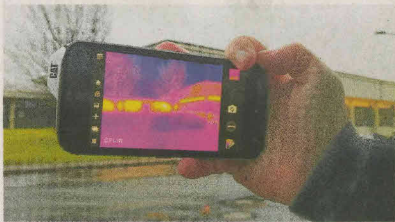
Die Selma-Lagerlöf-Oberschule in Harsefeld liegt auch im Sanierungsgebiet und hat deutlich erkennbar erhebliche Wärmeverluste.
